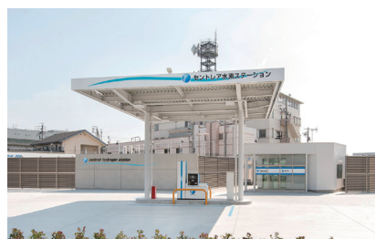
セントレア水素ステーション(愛知県)
