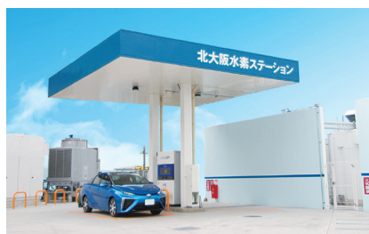
北大阪水素ステーション(大阪府)
