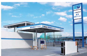
東浜水素ステーション(福岡県)
