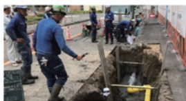
配管を1往復で動画撮影
