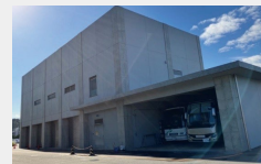
設備棟 浸水対策のため1階を駐車場等とし、受変電設備、非常用発電機、給水設備など主要設備は2階に設置
