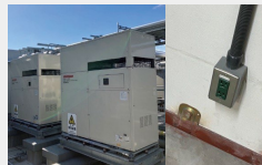
コージェネ 災害時にも電力供給可能な停電時自立型を採用。写真(右)は停電時にも優先的に使用可能なコンセント
