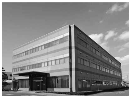
須山建設本社ビルの外観
