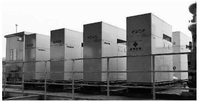
屋上にコージェネ10台を設置した
