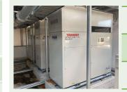
排熱投入型吸収冷温水機633kW(633kW×1台)
