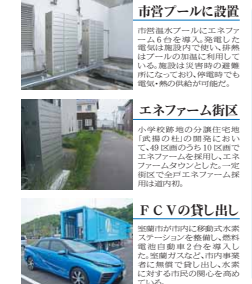
市営プールに設置 エネファーム街区 FCVの貸し出し
