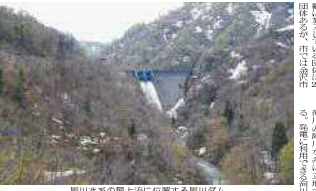
黒川水系の堰上流に位置する黒川ダム
