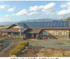
太陽光パネルを設置した管弦楽のり館
