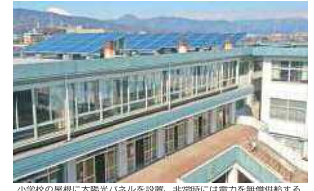
小学校の屋根に太陽光パネルを設置、非営利では電力を供給している
