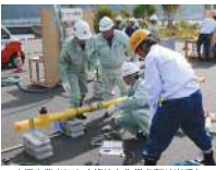
応急処置業者にも本格的な作業を割り当て
